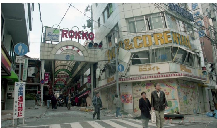
← 灘区森後町の六甲本通。 右側のビルは2階が崩壊。 左に傾いている。 1995年1月17日撮影 〈写真提供＝神戸市〉
