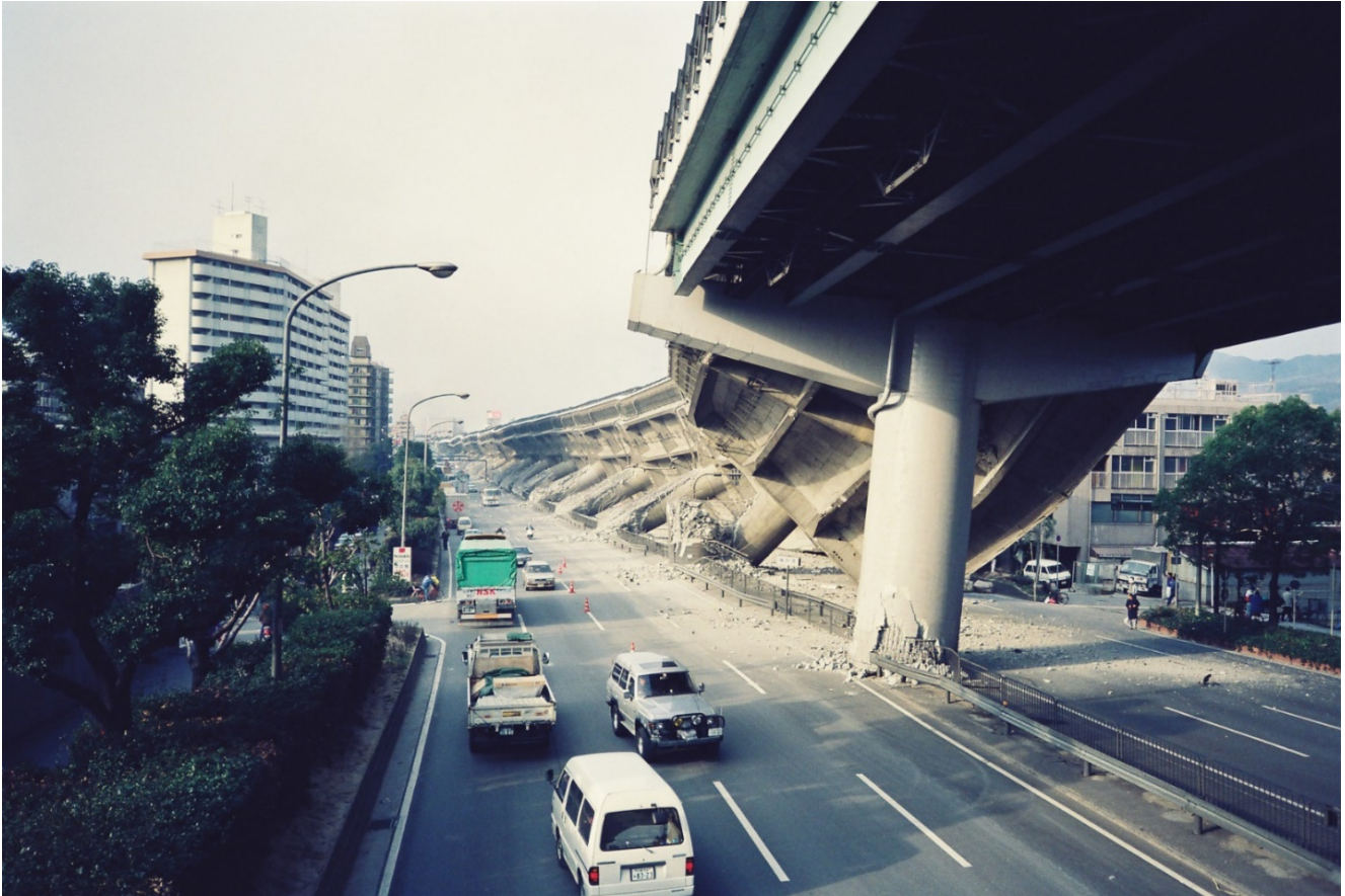
↑ 倒壊した阪神高速神戸線。東灘区深江南町。1995年1月17日 午前9時ごろ撮影 <写真＝神戸大メディア研／ニュースネット>
