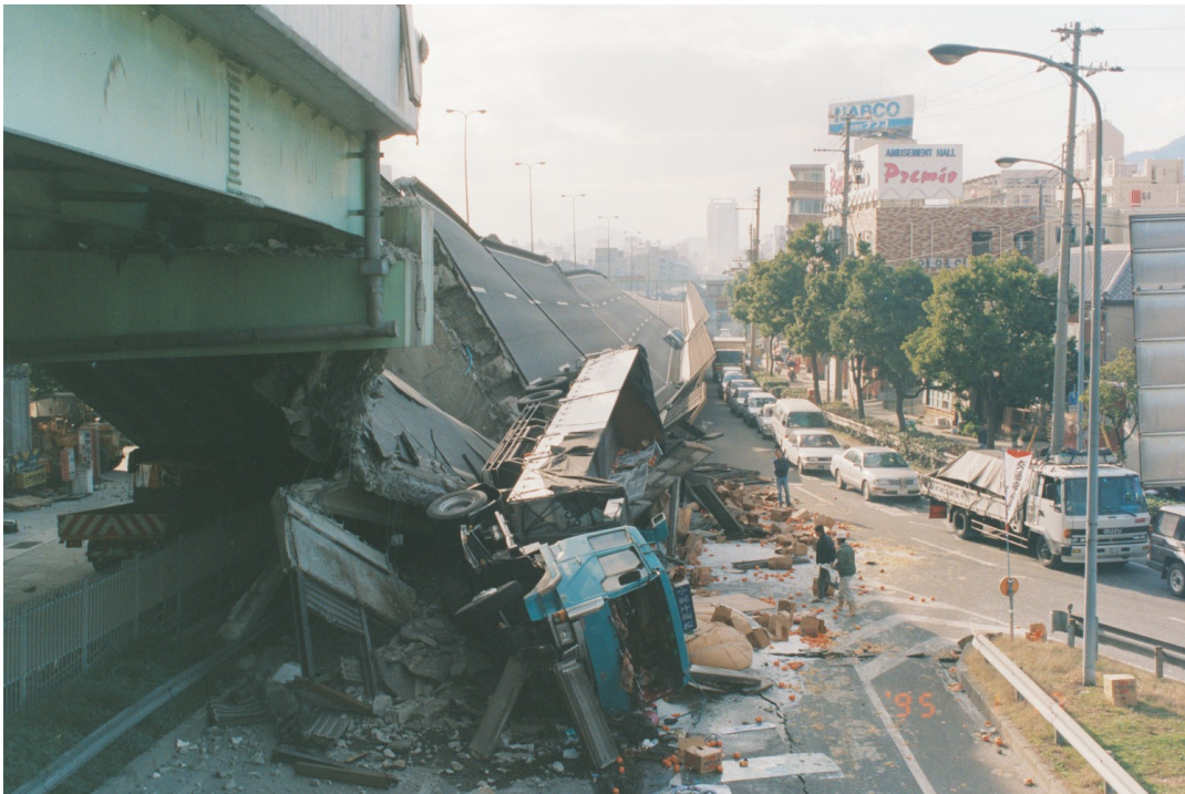
↑ 灘区国道43号線岩屋交差点周辺。高架が落橋した。 1995年1月17日撮影 <写真提供＝神戸市>
